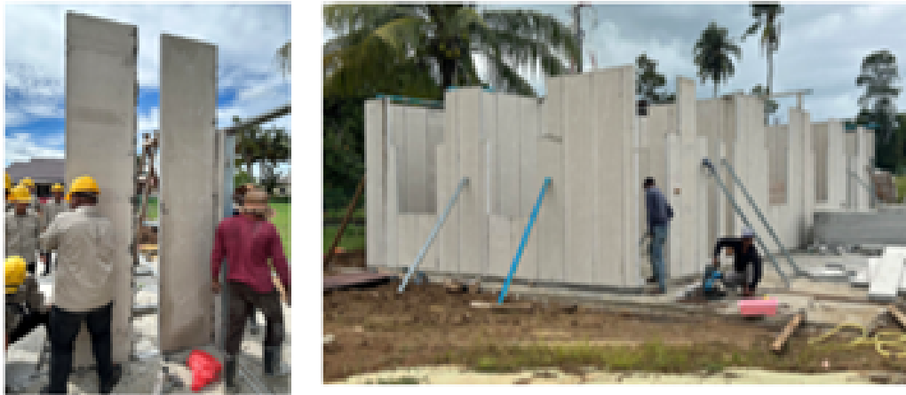
Pemasangan Wall Panel (11 - 16.07.2023)
